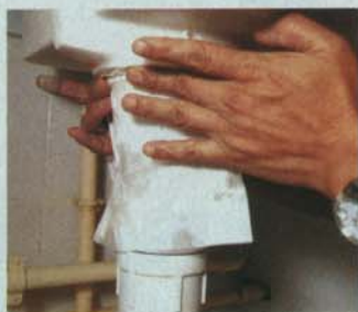
▲以紙巾輕放在水喉旁，漏水即時遁形。
