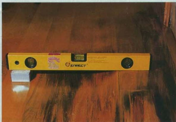
走廊的橡木地板嚴重發黑，高低位相差三十毫米，慘不忍睹。(黃綺珊攝)
