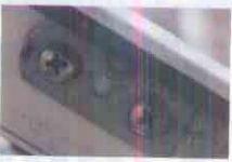
盛富、盛樂樓鋁窗這位置都只有一口拉釘（上圖），而其餘五座則有兩口拉釘；整隻窗少兩口拉釘，導致盛富、盛樂這兩座樓跌窗。
