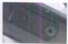
位置都只有一口拉釘（上圖），而其餘五座則有兩口拉釘；整隻窗少兩口拉釘，導致盛富、盛樂這兩座樓墮窗。
