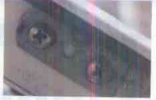
位置都只有一口拉釘（上圖），而其餘五座則有兩口拉釘；整隻窗少兩口拉釘，導致盛富、盛樂這兩座樓墮窗。
